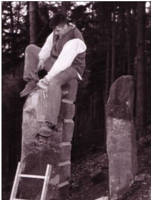
Abbildung 3: moderner Handwerker arbeitet mit mittelalterlicher Technik (1998)
